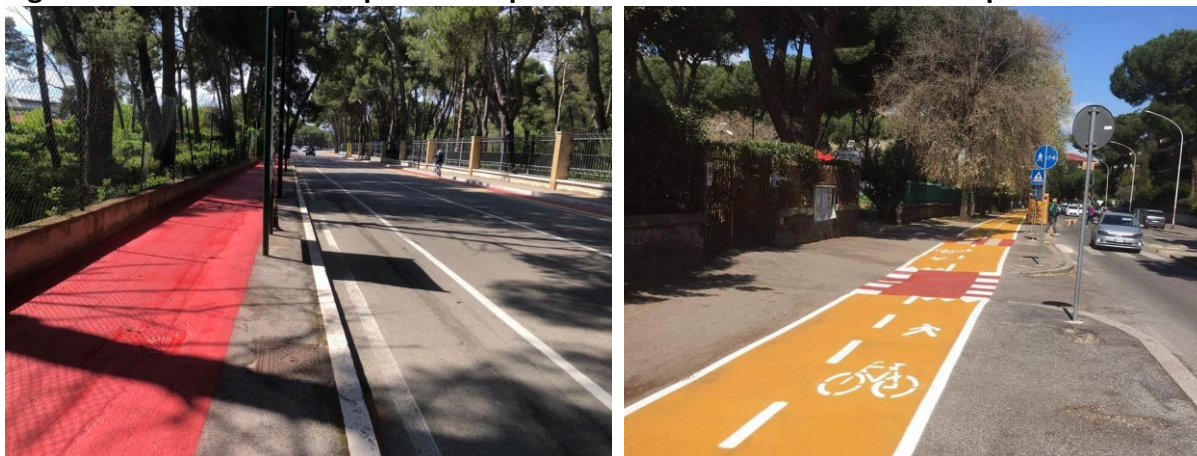
Figure 2.11 e 2.12 Esempi errati di piste ciclabili bidirezionali su marciapiede
